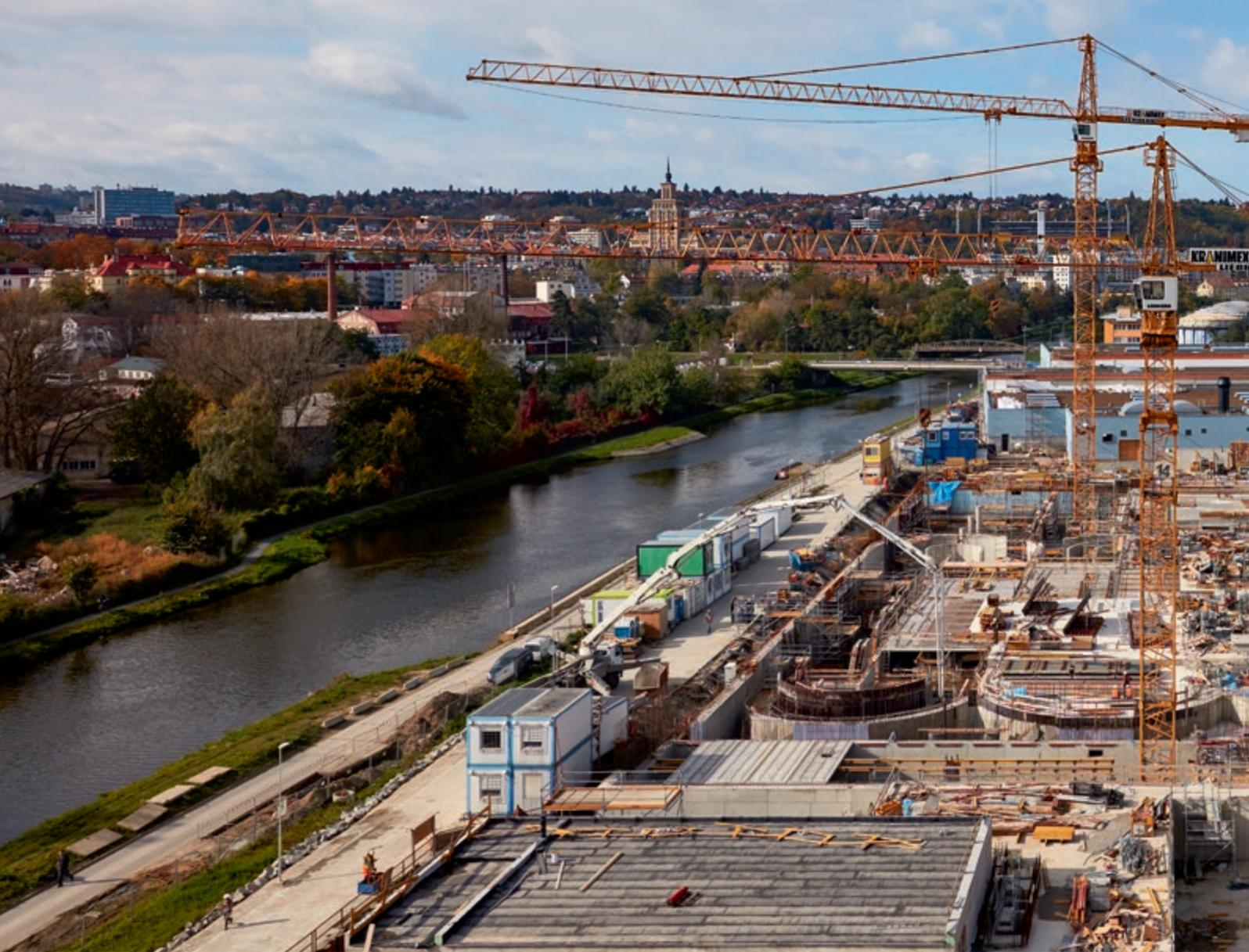
Ende 2018 soll in Prag eine neue Kläranlage mit einer Kapazität von 1,2 Millionen Einwohnerwerten in Betrieb gehen. Sie wird 600 Meter lang und 130 Meter breit sein. Im Normalbetrieb wird sie etwa 4,1 Kubikmeter Abwasser pro Sekunde behandeln, also ca. 15 Millionen (!) Liter pro Stunde.
